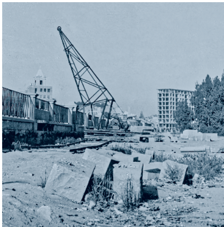
Grúa trabajando en la instalación de la nueva balastrada del río en el primer tramo de Vistabella, 1965 (cedida por Esteban Linares Ros)
